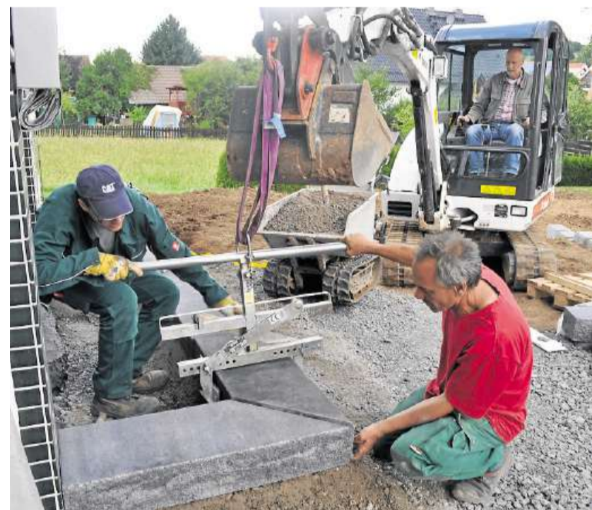
André Ruhl (links), Günter Bretthauer und Stefan Krauss (im Bagger) beim Setzen der Steine für das Podest.
